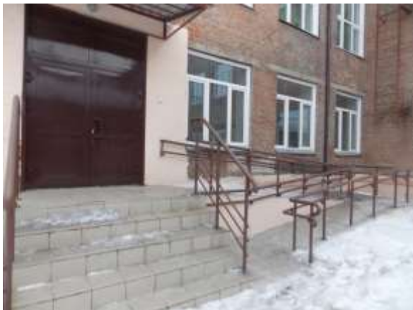
Фото № 6 – вход в здание
