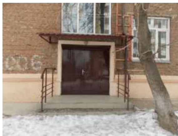
Фото № 5 – вход в здание
