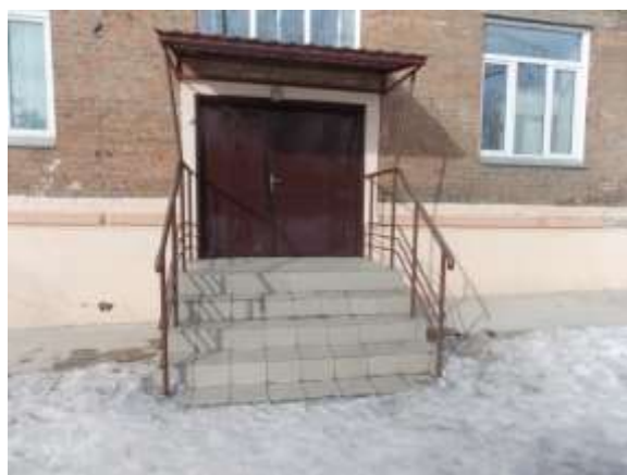
Фото № 4 – вход в здание
