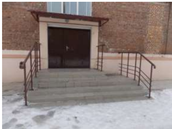
фото № 7 – вход в здание
