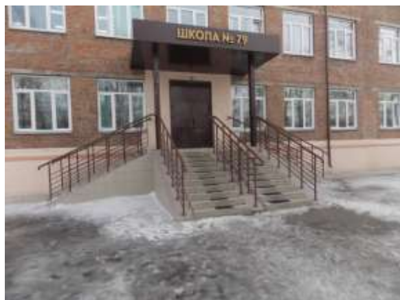
Фото № 1 – вход в здание
